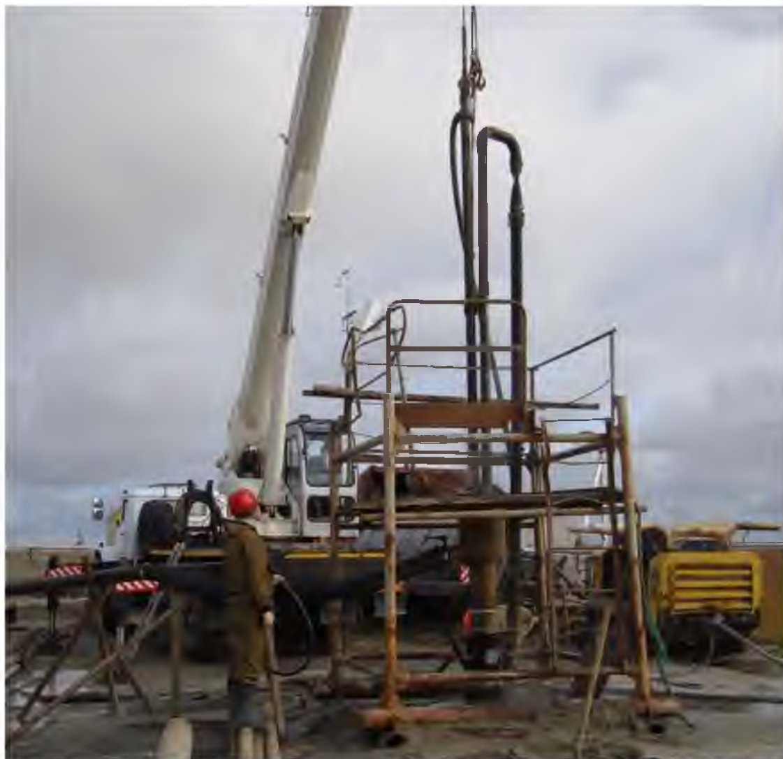
Рисунок 4.10 – Фотография площадки строительства подземного резервуара
